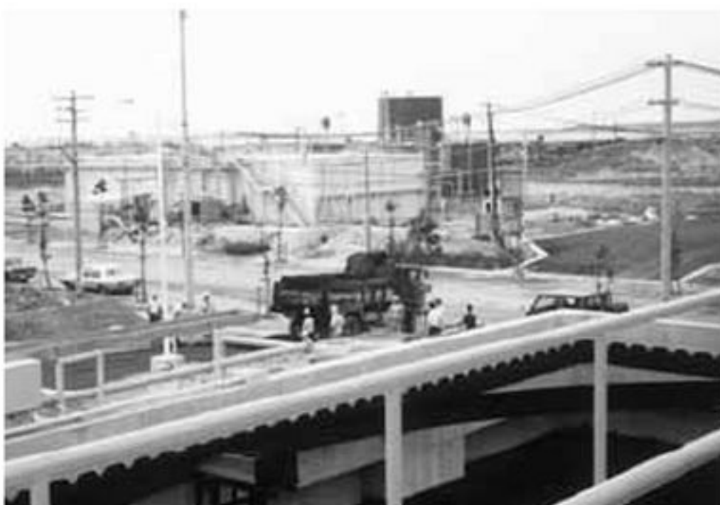
用水設備建設中
