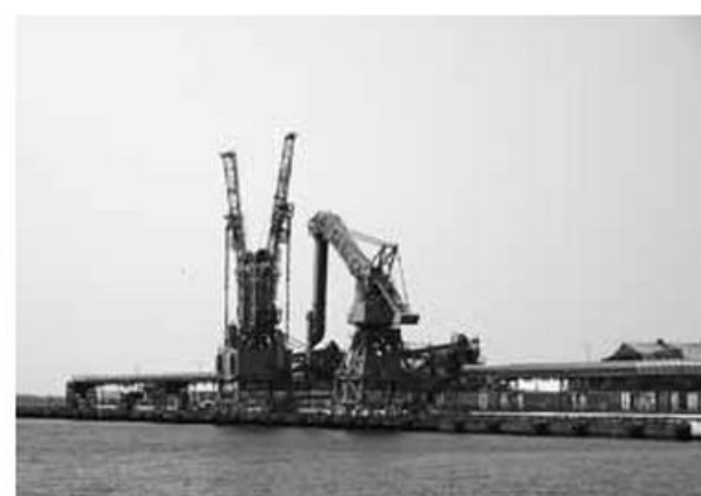
博多港アンローダー
