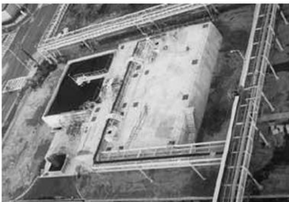
排水設備建設中
