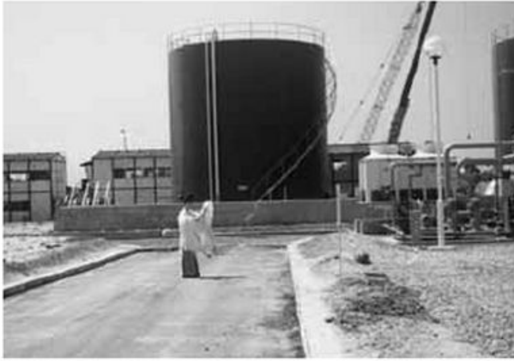
灯油ボイラ起工式
