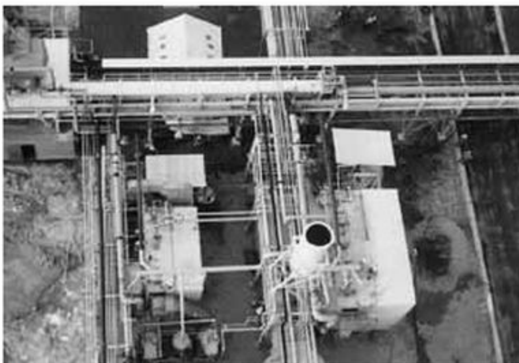
灯油ボイラ建設中
