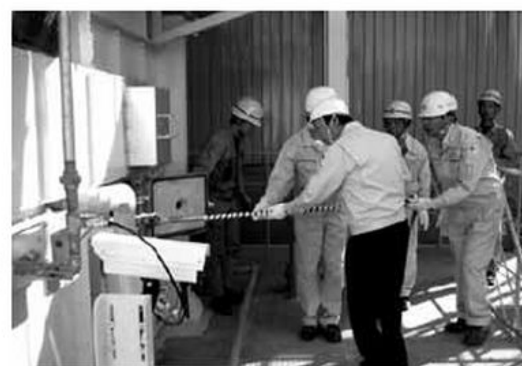
25t 木屑ボイラ火入れ式（平成17年11月）
