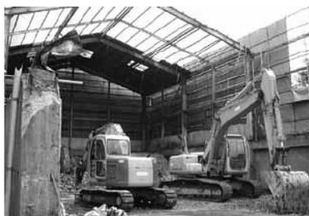
15t木屑ボイラ設備解体(平成17年7月)
