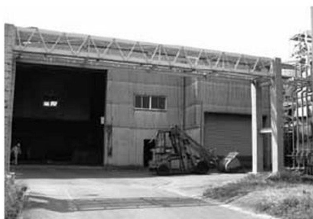
木屑受入倉庫
