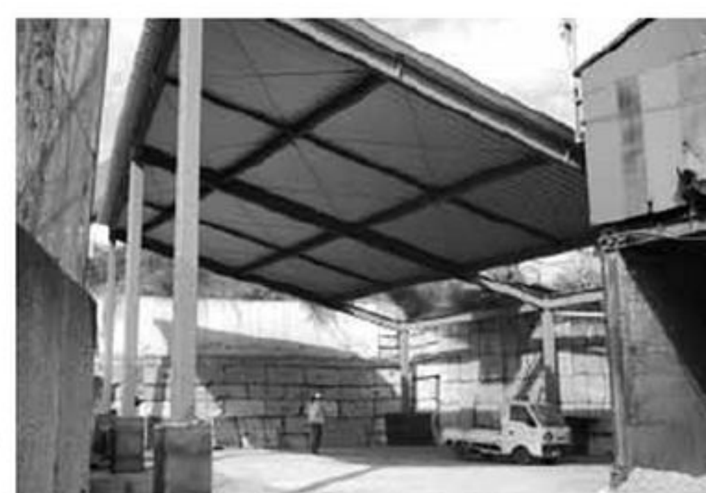
中山リサイクル産業 チップ置場改修 (平成21年10月)
