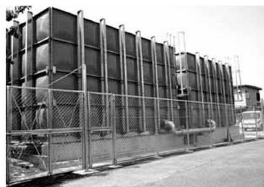
滅菌水槽増設(平成25年3月)
